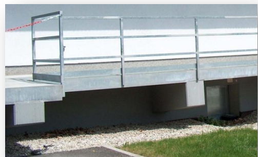
Traversen mit Pfosten verschraubt
