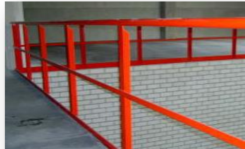
Traversen mit Pfosten verschraubt
